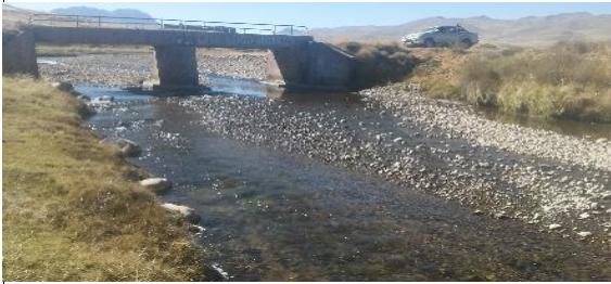
FOTO 01: Se aprecia el curso del agua de caudal permanente, riberas con taludes naturales aguas arriba y abajo del puente Hanocca, se encuentran afectados las riberas por erosión.
