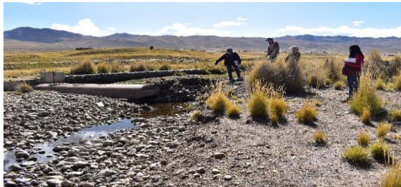
FOTO 04: Bocatomas existen y afectado el barreja por erosión que beneficia a la comite de usuarios de agua CANAL C.
